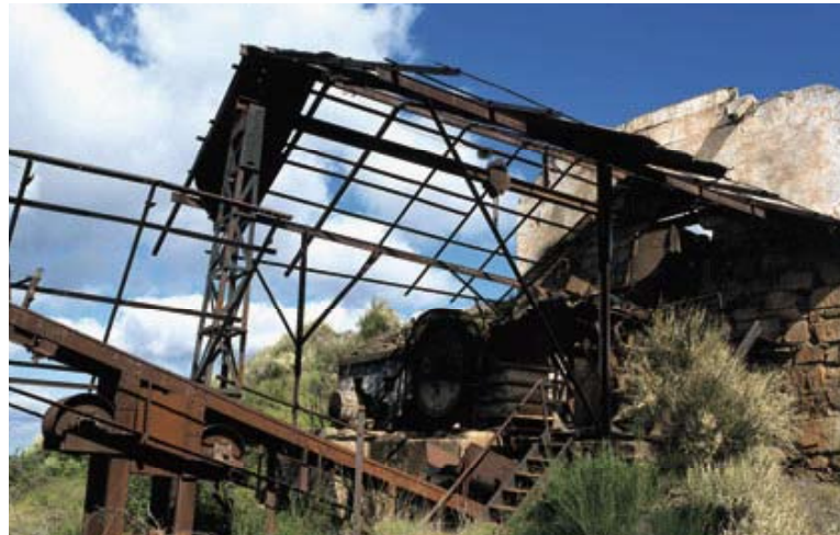
Fig. 1 – Antigas instalações da Ferrominas
